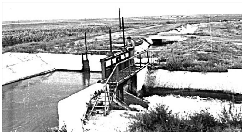
Главное сооружение Ташебинской и Центральной ветки Абаканского магистрального канала.
