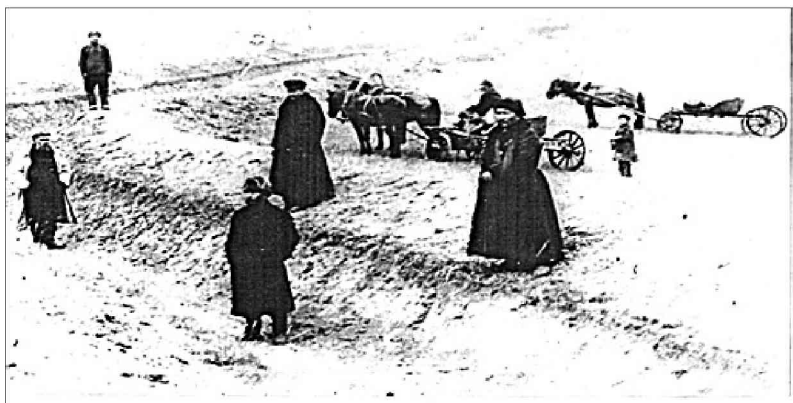
Уйбатский канал после реконструкции. 1927 год
