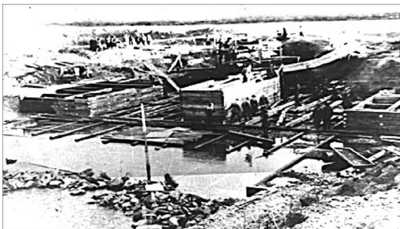
Строительная площадка головного шлюза Абаканского магистрального канала. 1948 г.
