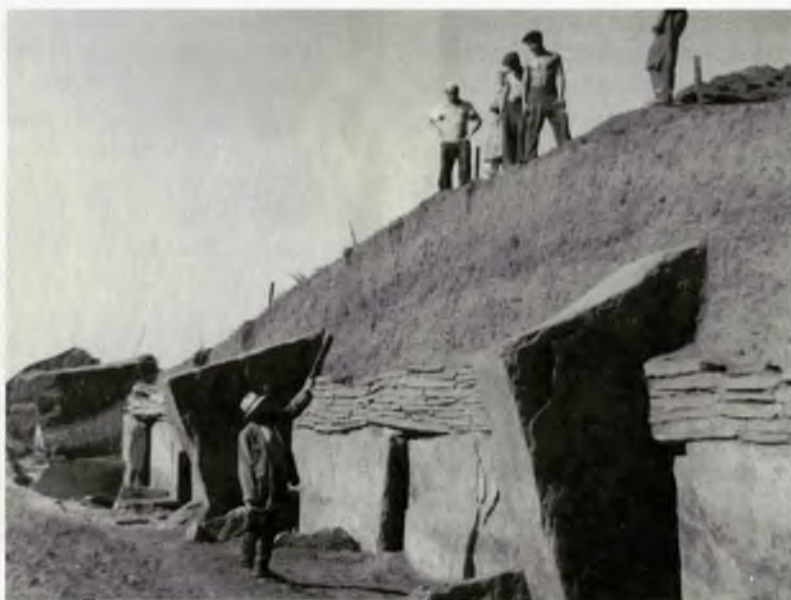
Перед началом вскрытия насыпи. 1954 г.
