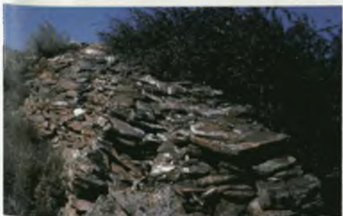
Кладка оборонительной стены
