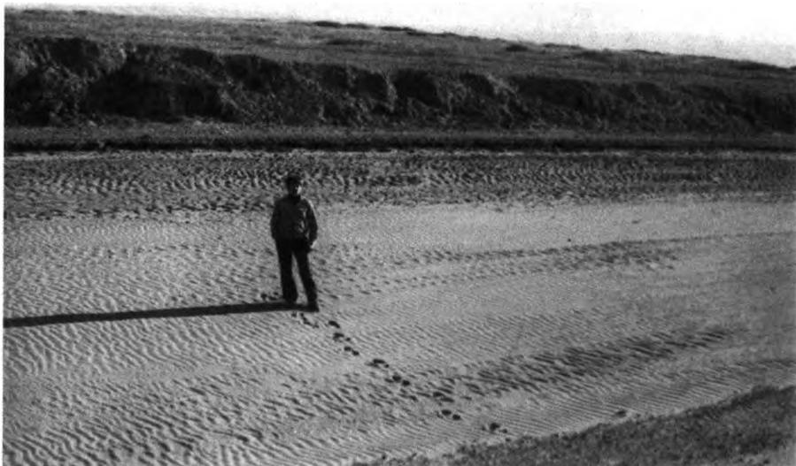
Разрушение ветром откосов магистрального канала и отложение в нем мелкозема.
