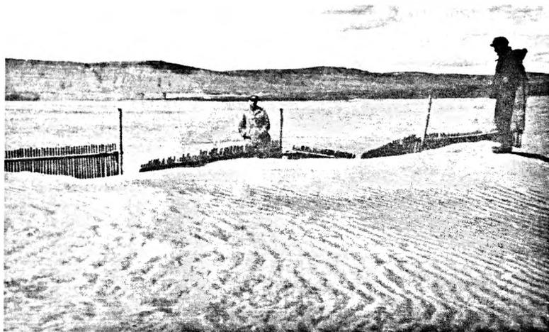
Фото 1. Отложение мелкозёма у механических преград (деревянных щитов) на опытном участке Хакасского противозрозионного стационара, апрель 1961 г. У щитов стоят М.Н. Польский (слева) и С.М. Поршин (справа).
