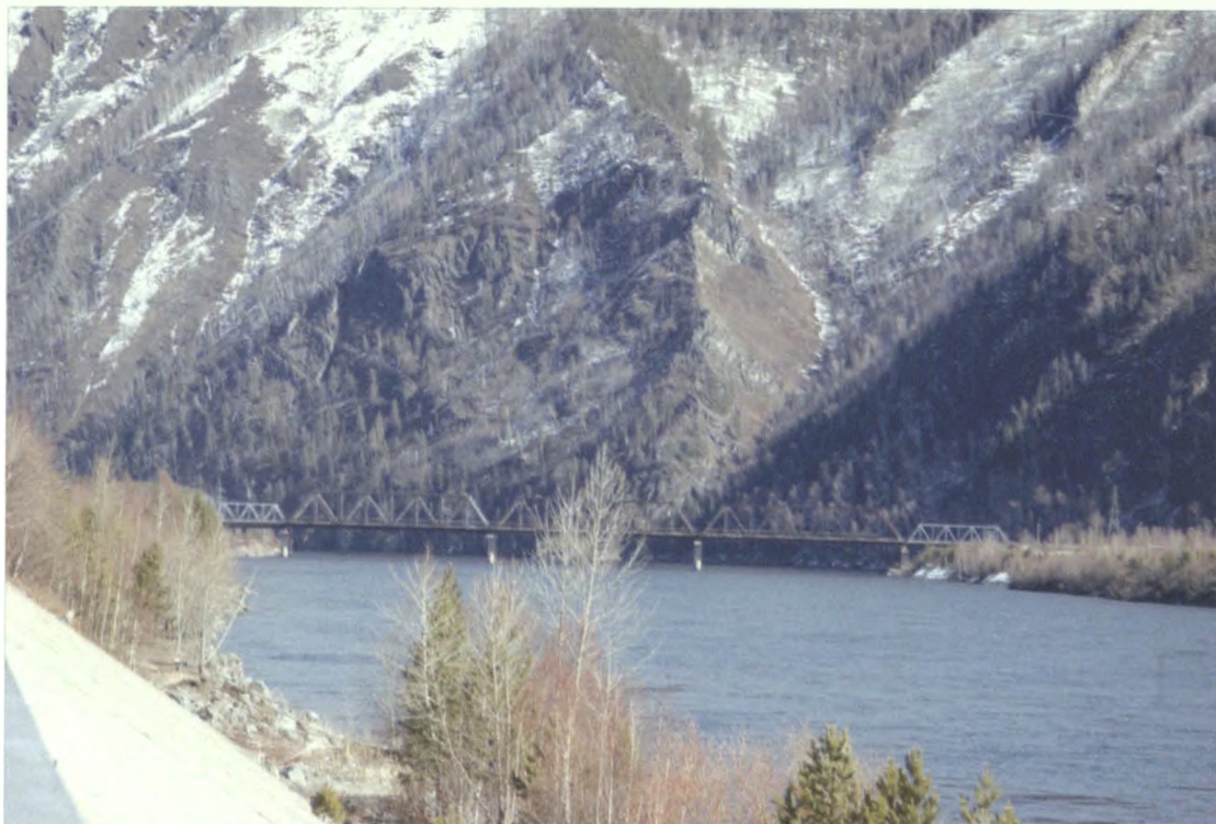
Большая работа мостостроителей республики
